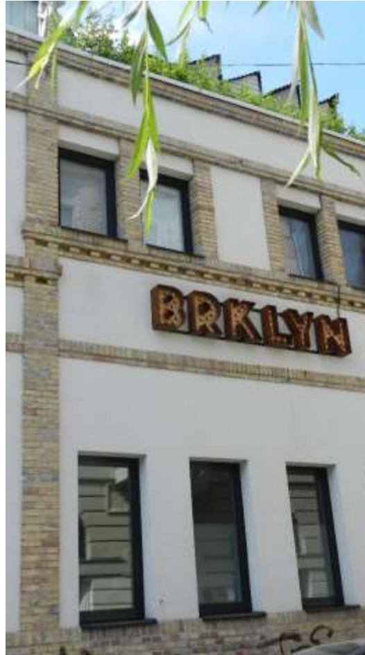
Felújított egykori trafóház
