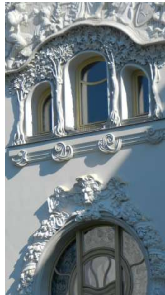
Városligeti fasor 45. alatti épületszecessziós ablakai
