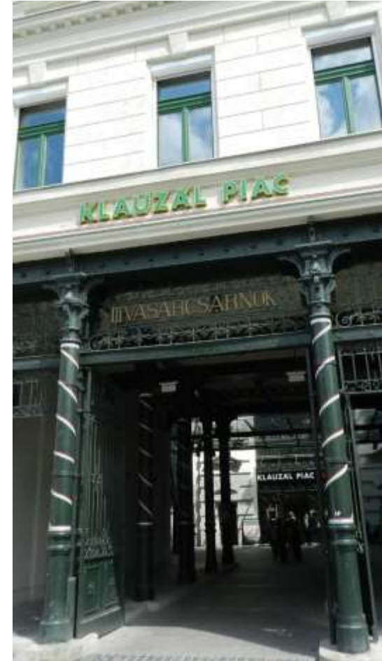
Klauzál téri csarnok felújított bejárata
