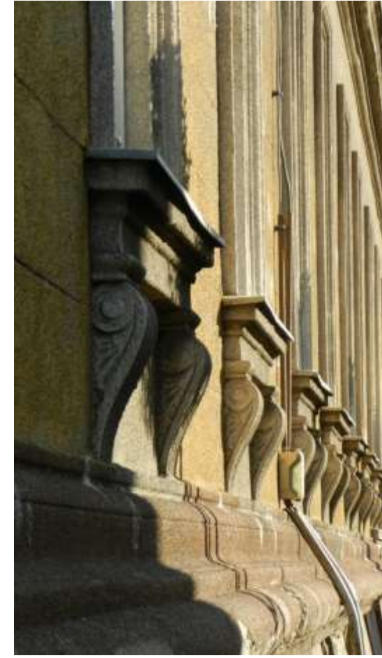
Plasztikus homlokzat a Dohány utca 79-ben
