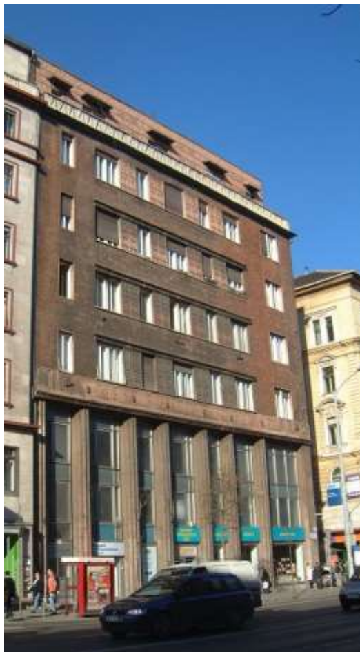
Volt Erzsébetvárosi Takarékpénztár cím: Rákóczi út 18, Hrsz: épült: 1911 tervezte: Lajta Béla
