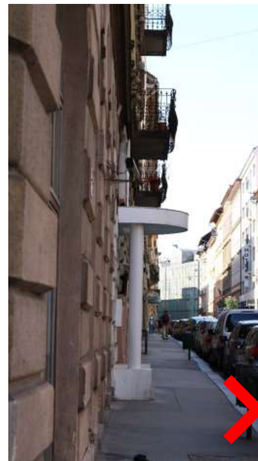
Utólag építetett előtető, amely nem szerves része a homlokzatnak (Szövetség utca)
