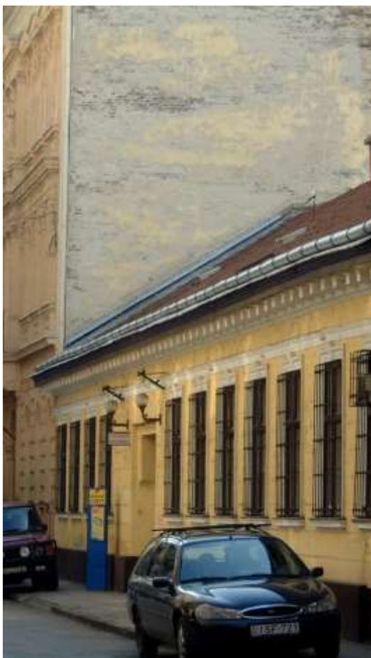
Egykori műhely épület cím: Nagydíófa utca 8. hrsz: 34471 épült: 1874 tervezte: Hild Károly Eklektikus, földszintes épület
