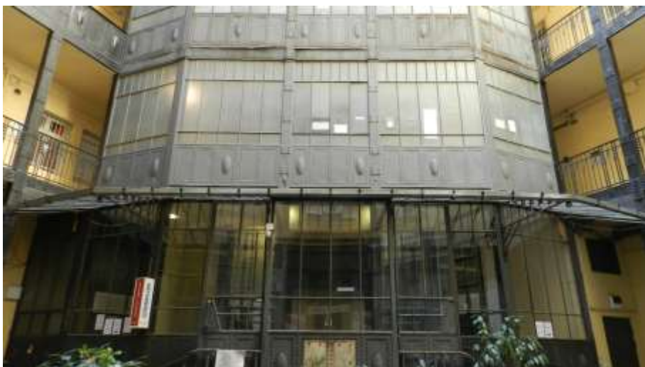
Fém szerkezetű belső homlokzat
