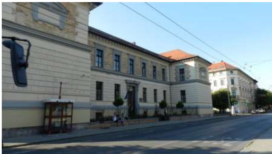
Kerítés a Rózsák terénél
