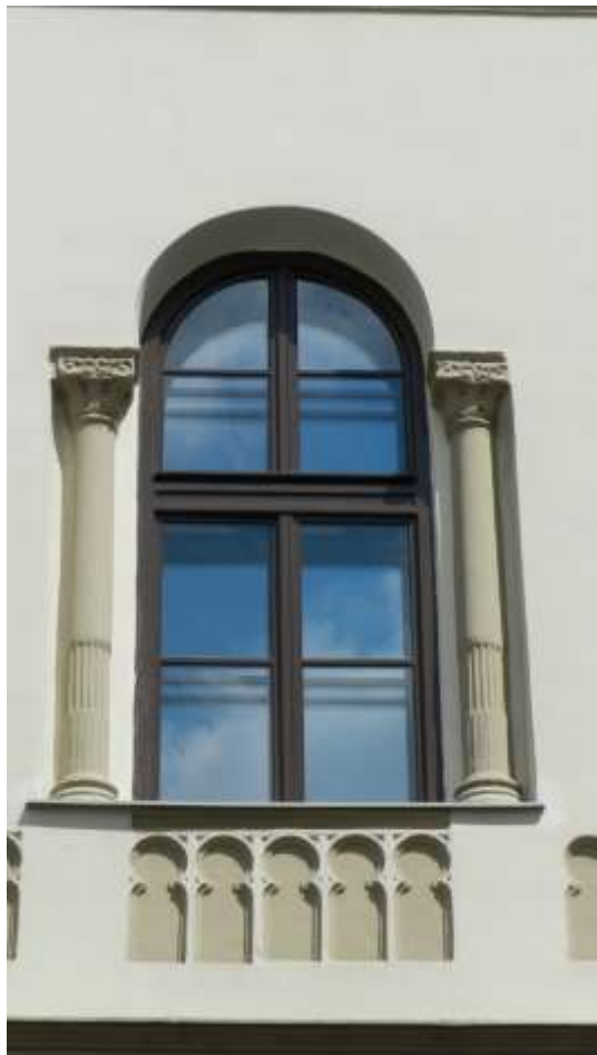
ELTE épületének felújított ablakai
