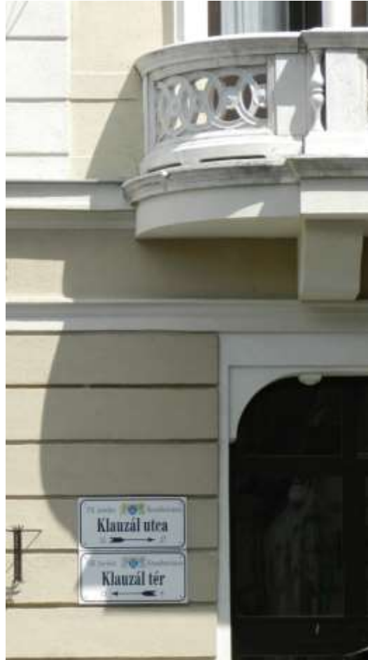
Homlokzatrészlet klauzál tér
